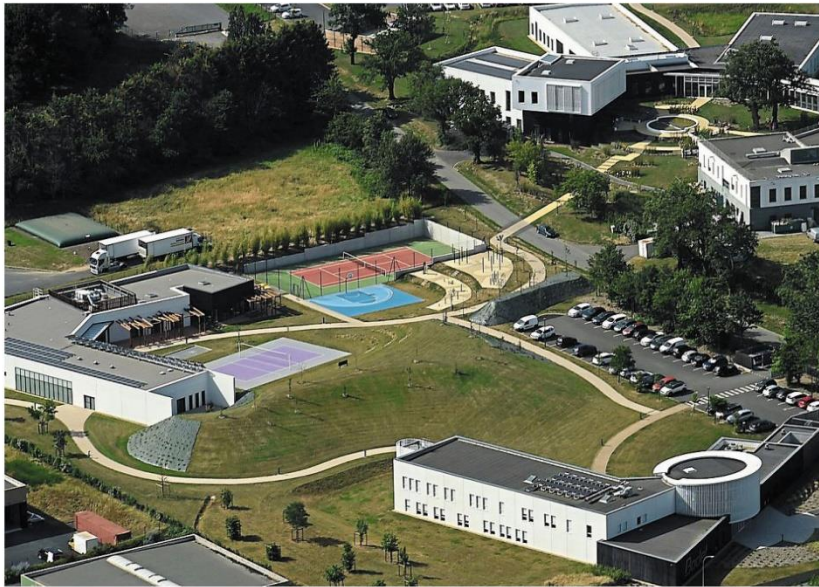
Cholet, zone du Cormier, juin. Au premier plan à droite, le nouveau siège du groupe Bodet. Au second plan, les terrains de sport et le nouveau restaurant de la filiale Bodet Software, dont les bâtiments forment une main en surplomb (haut de la photo).
