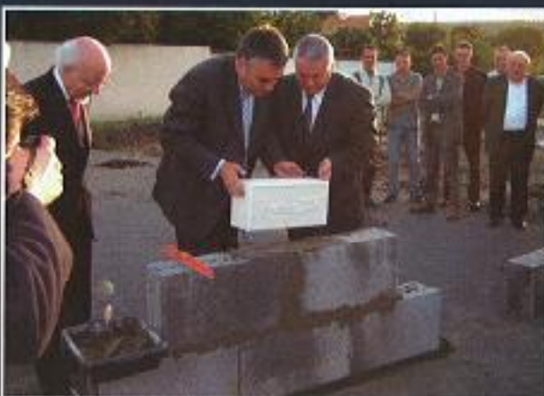
Pose de la 1 ère pierre du centre d'hébergement de Cholet Basket le samedi 7 octobre 2006.
