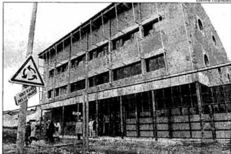
Gilles Bourdoux, député-maire de Cholet, a conduit hier matin une visite des locaux qui seront en chantier jusqu'au mois d'août. Les joueurs du centre de formation emménageront début septembre
