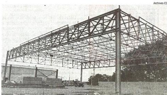
A l'été 1987, le chantier de la Meilleraie prend des allures de challenge : tout doit être bouclé en 70 jours ! Défi relevé. Le match CB-Lorient inaugurerait les lieux.
