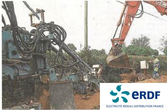
Un engin spécialisé creuse la tranchée, déroule et pose le câble, lequel est ensuite enfoui et sécurisé par un filet orange.
