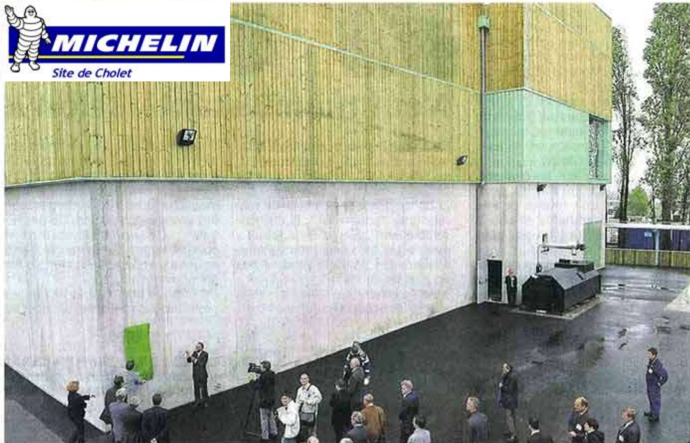
Cholet, usine Michelin, hier midi. Un bâtiment avec un bardage en bois protège la nouvelle chaufferie de 14 millions d'euros. Photos CO : Etienne LIZAMBARD
