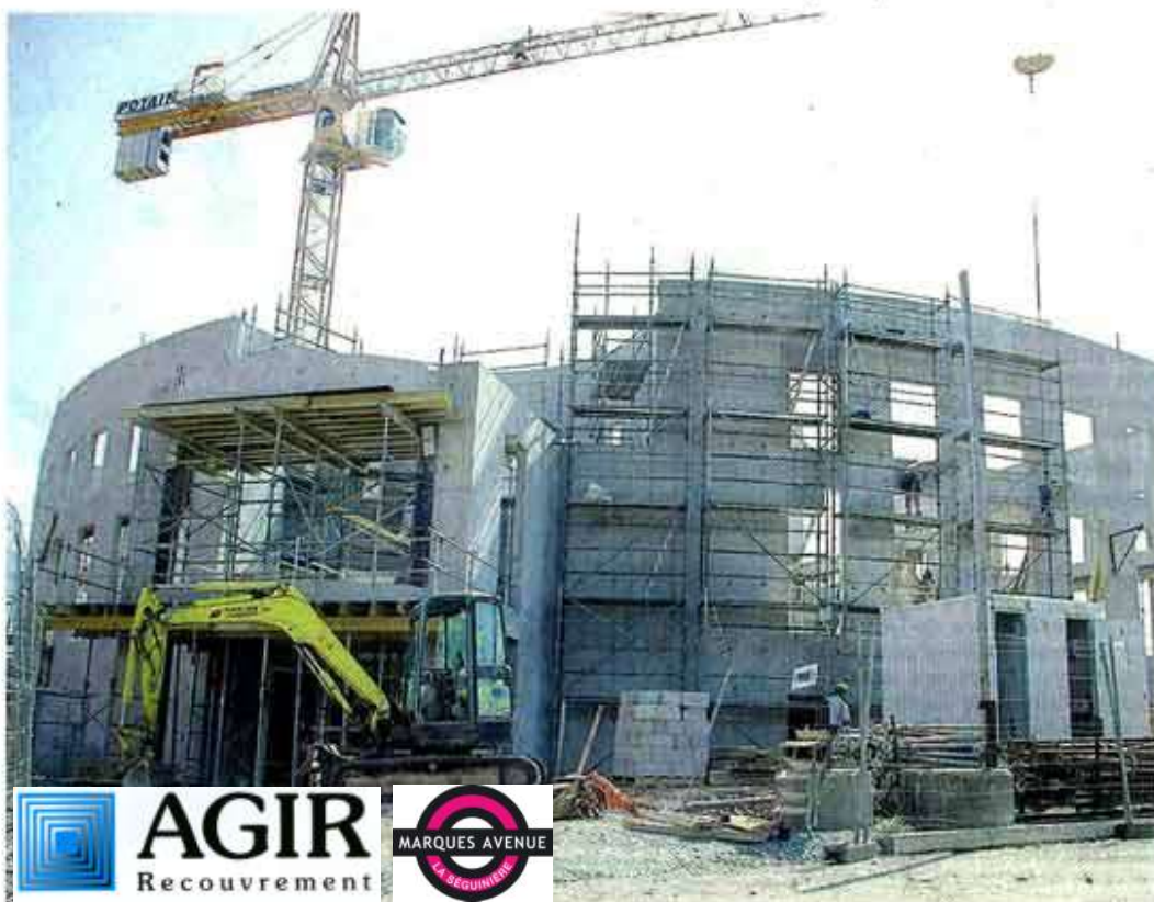
Cholet, L'Ecuyère, hier. La société Agir Recouvrement de Stéphane Paye déménagera dans quelques mois dans son nouveau siège social, en cours de construction sur cette zone d'activités tertiaires.
