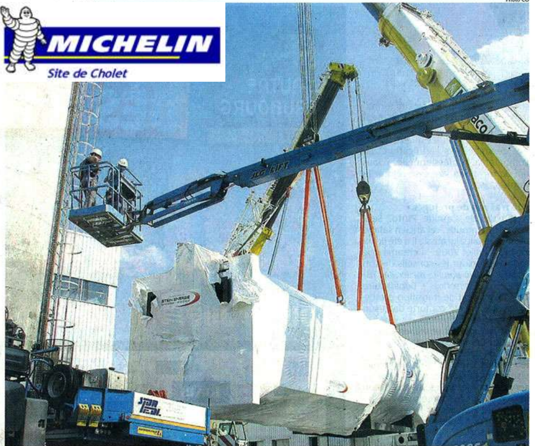
Cholet, hier. Deux grues de 250 tonnes ont soulevé la chaudière de 110 tonnes et l'ont déposée sur des chariots pour qu'elle soit glissée au pied de l'immense cheminée Michelin où se trouve la chaufferie.
