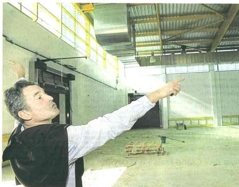
Saint-André-de-la-Marche, lundi 16 mars. Benoît Mary dans le nouveau bâtiment en construction sur la zone Actipôle. Le chauffage et l'eau chaude sanitaire de l'immeuble seront entièrement assurés par des sources d'énergies renouvelables. Photo CO - Etienne LIZAMBARD.
