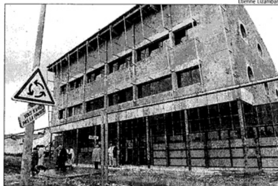
Gilles Bourdouleix, député-maire de Cholet, a conduit hier matin une visite des locaux qui seront en chantier jusqu'au mois d'août. Les joueurs du centre de formation emménageront début septembre ment de 1 050 000 € bénéficie de subventions de la Région, du Conseil général et de la Communauté d'agglomération du Choletais. AT
