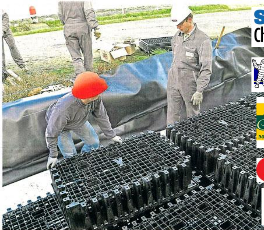
Ces modules de plastique cr es et fabriqu s par la soci t  Nicoll de Cholet s'enterrent sous un parking ou une chauss e. Ils r sistent   la pression des v hicules. Les alv oles permettent le stockage des eaux de ruissellement   la mani re d'une  ponge. Cette eau a tout son temps ensuite pour s'infiltrer et recharger les nappes phr atiques comme la nature sait le faire en rase campagne. Photo Nicoll.
