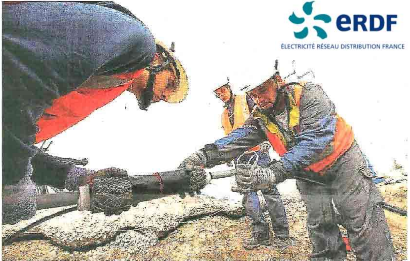
Le remplacement des câbles en papier huilé des années 50 par des fibres synthétiques fait partie de l'entretien du réseau.
