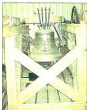
Le beffroi en bois dans son ensemble, entièrement fabriqué à Trémentines. Il soutient l'ensemble campanaire composé de la cloche évidemment mais aussi du mouton - la pièce de bois qui la soutient. Celui-ci est entièrement chevillé avec du bois
