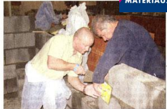
Pose de parpaings ou de briques, installation de cloisons sèches... Toutes les techniques de gros ou de second œuvre font l'objet de formations courtes
