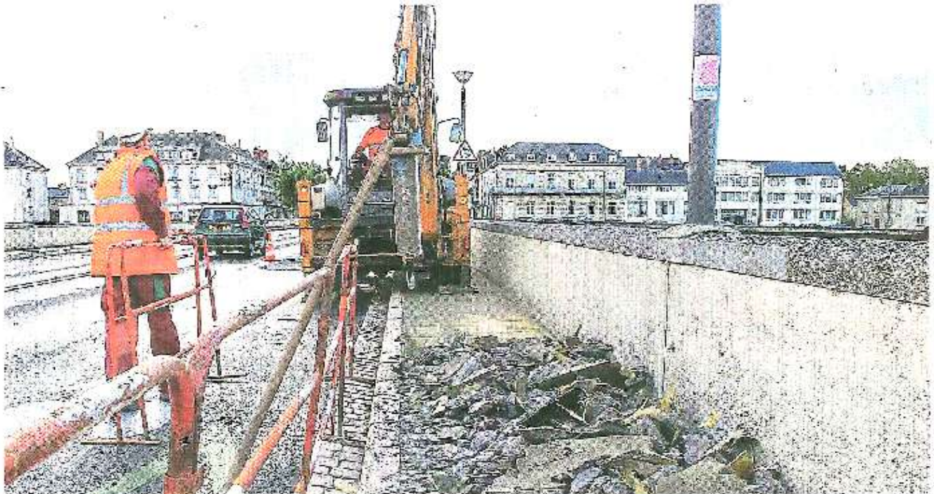
Saumur, pont des Cadets, mardi. Le marteau-piqueur a défoncé le trottoir afin d'accéder aux câbles souterrains enterrés dans le pont.
