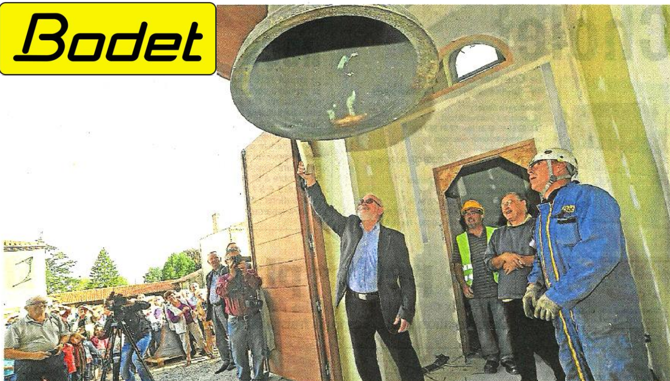
La Tourlandry, église Saint-Vincent, hier. Les trois cloches ont été hissées par l'entreprise Bodet dans le nouveau beffroi. Photo CO - Etienne LIZAMBARD.
