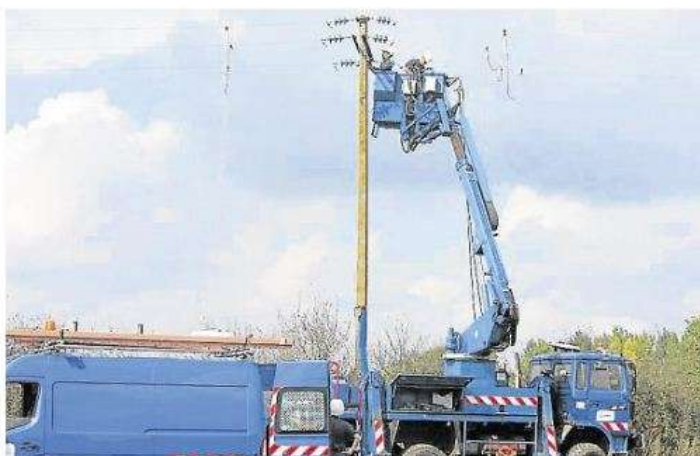
L'équipe de techniciens ERDF change les six ancrages au poteau électrique.
