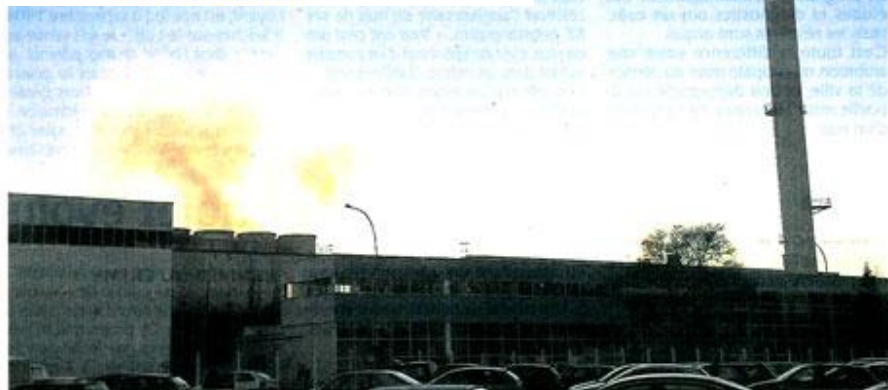
Cholet, hier. L'usine Michelin de Cholet produit actuellement la vapeur d'eau nécessaire à la cuisson des pneumatiques, avec une chaudière à gaz. Une chaudière à bois sera installée pour compléter le dispositif et réduire les émissions de gaz carbonique.
